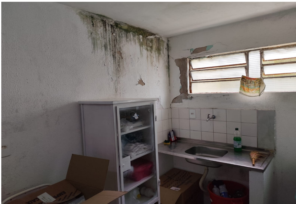
1º Andar com infiltrações e fios expostos.
