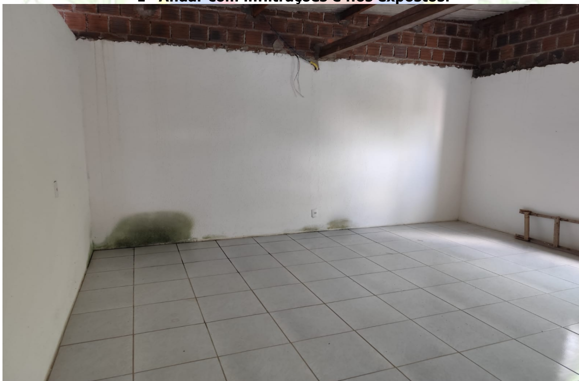
1º Andar com infiltrações e fios expostos.
